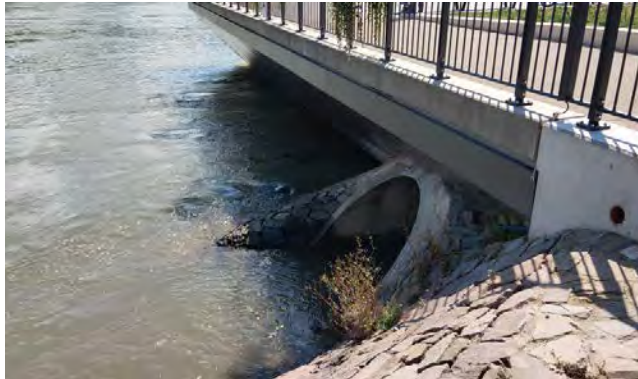
Abbildung 85 St. Goar, Abfluss des Lohbachs unter dem Rheinbalkon (Quelle: Hochschule Koblenz/Kimmel 2020), Einlauf des Lohbachs in die Verrohrung, Rechen, der zu Verkläuerung neigt, Einlaufquerschnitt evtl. zu gering dimensioniert (Quelle: Hochschule Koblenz/Gelhard 2020)
