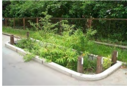
Abbildung 46: Mulden und Mulden-Rigolensysteme zum Wasserrückhalt (Quelle: Matzinger et al., 2017, S. 12–13; Fotos: IPS)
