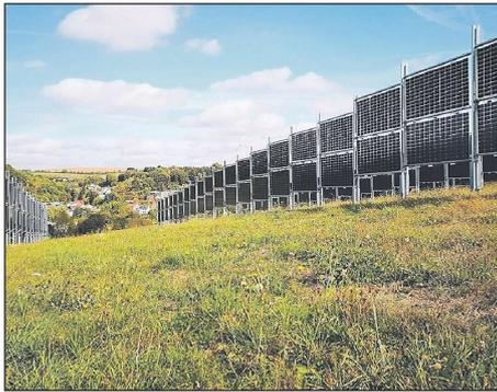
**Durch vertikale FV-Systeme kann der Flächenverlust gegenüber dem klassischen, schräg zur Sonne ausgerichteten System stark reduziert werden.**
