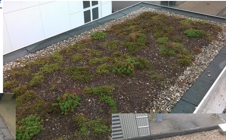
Dach mit extensiver Begrünung
