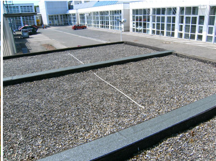
Kiesdächer: Bitumen-Dachpappe und 3 - 5 cm Kiesschicht
