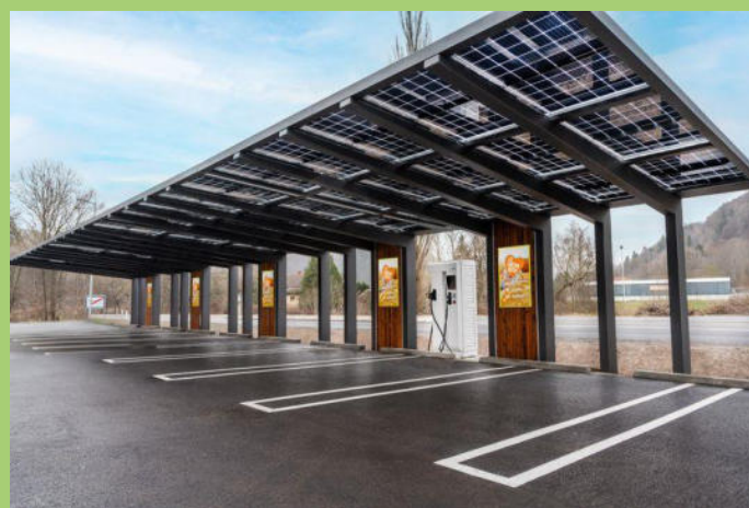
Abb. 2: Ladesäulen mit Solarüberdachung
