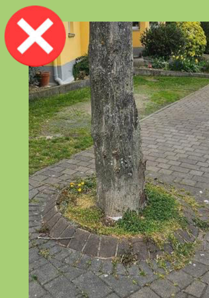
Abb. 2: Zu klein und zu hoher Rand; Regenwasser fließt nicht Richtung Stamm!
