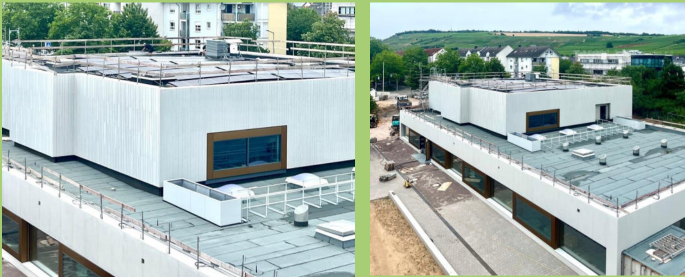
Abb. 1 und Abb. 2: Blick auf das Audimax-Dach der TH Bingen
